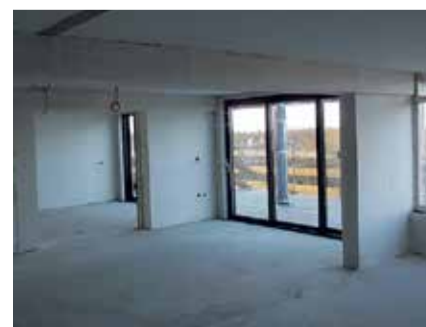
Bestaande woonunits worden doorgebroken tot grote huiskamers met nieuw balkon.
